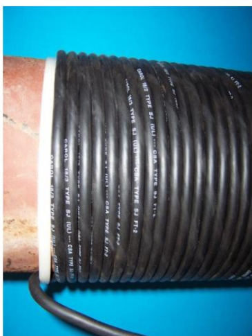
Fotografía 4a y 4b: ejemplos de cables de señal bien envueltos
